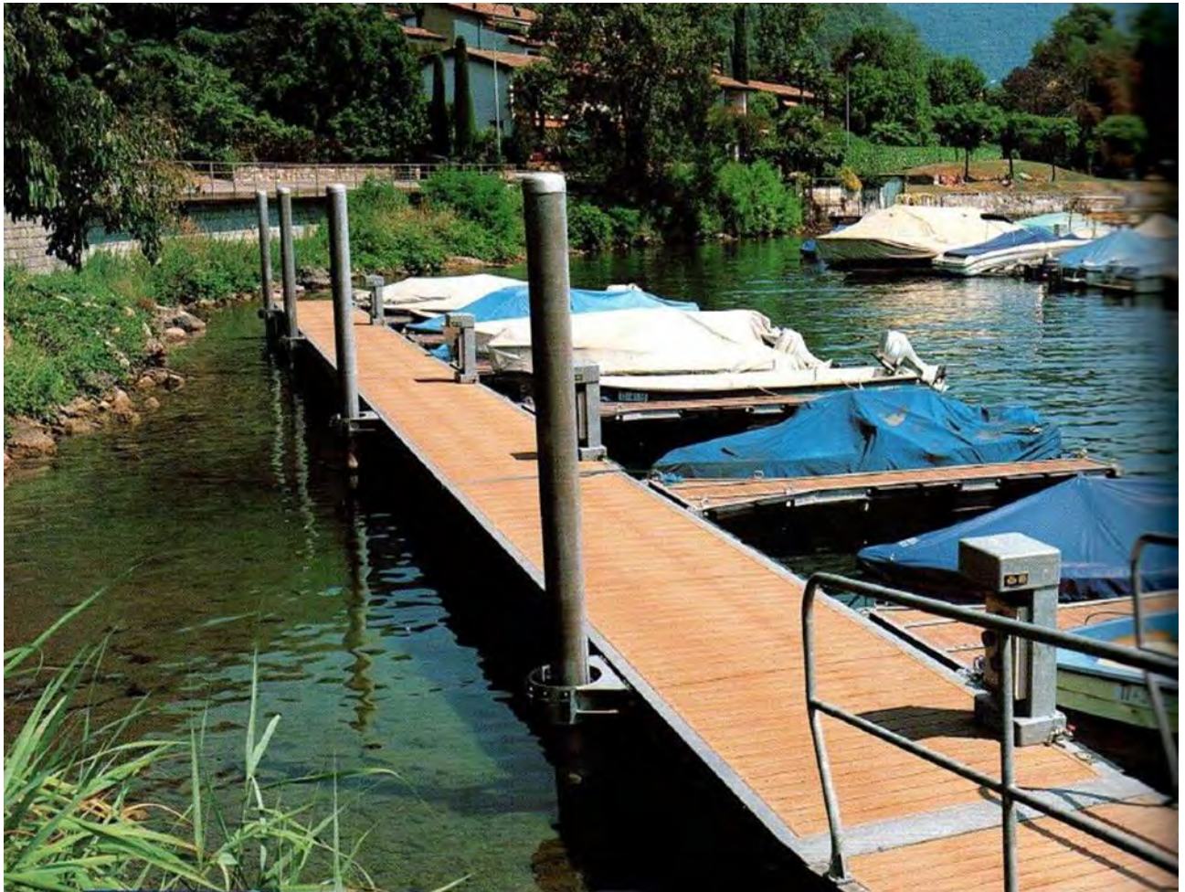
Слика IV.1.-Плутајући систем понтона фиксиран помоћу шипова (пример из Италије)
