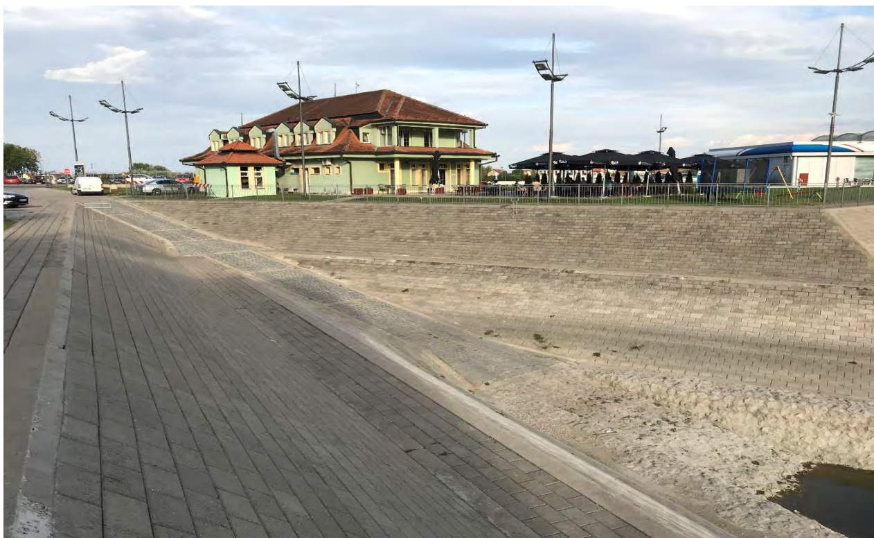
Слика IV.4.-Рампа за поринуће/извлачење пловила (марина Апатин)
